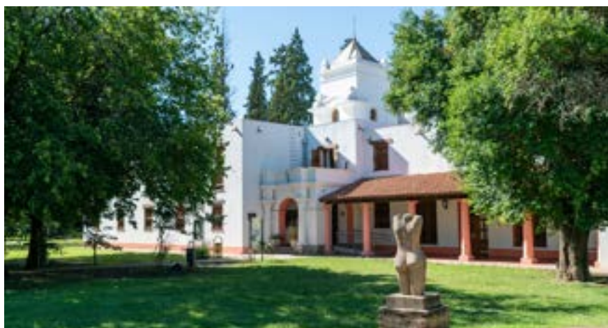
Pabellón México. Facultad de Artes
